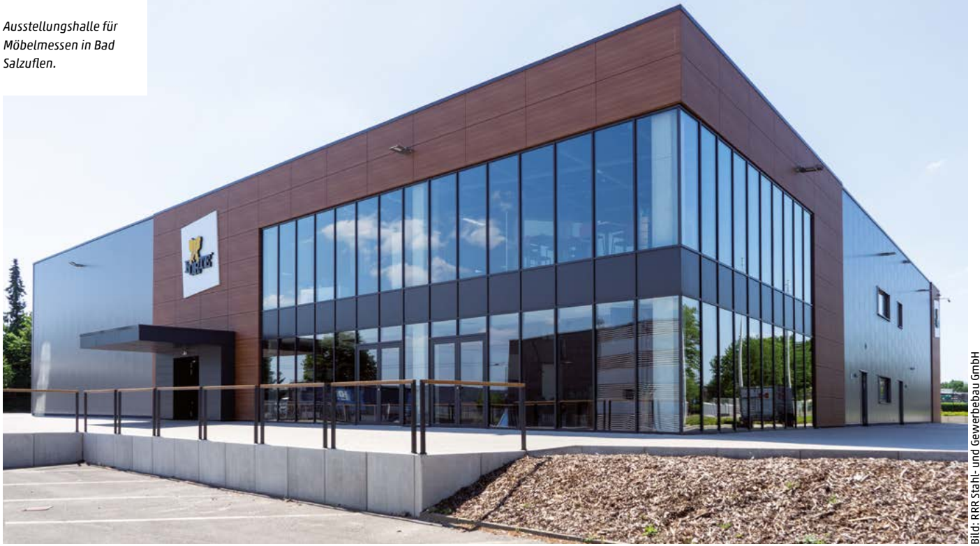
Bild: RRR Stahl- und Gewerbebau GmbH
