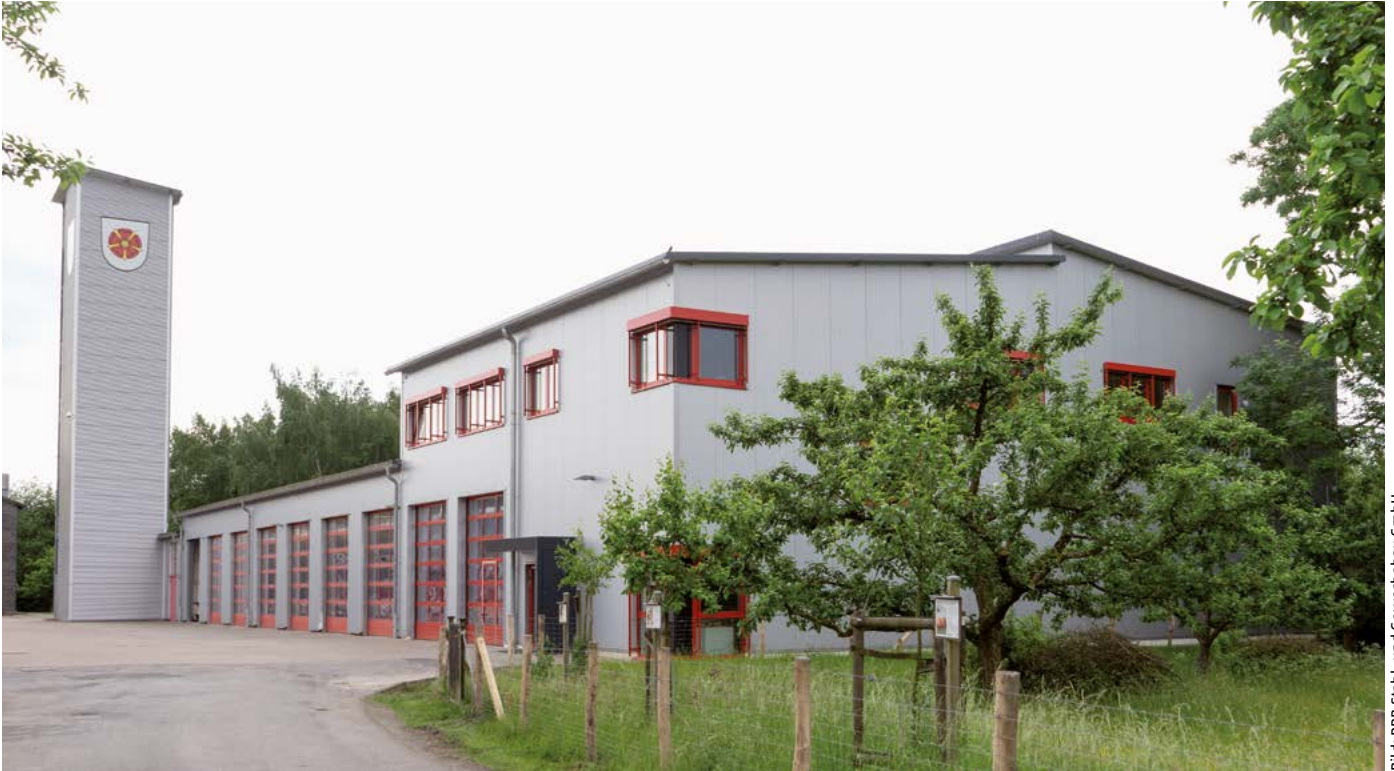
Feuerwehrausbildungszentrum Lippe in Lemgo
